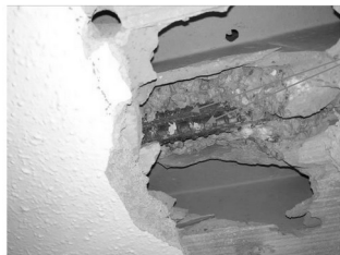
Ferrailage en partie inférieure des nervures, à mi-portée du plancher
